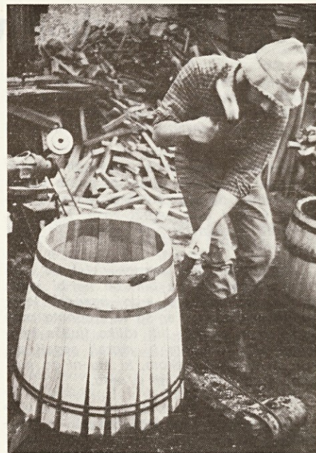
Sod je na spodnjem obodu vpet v zanko motornega vitla, ki postopoma zateguje jeklenico in doge krivi. Sodar nabija drugi obroč.
