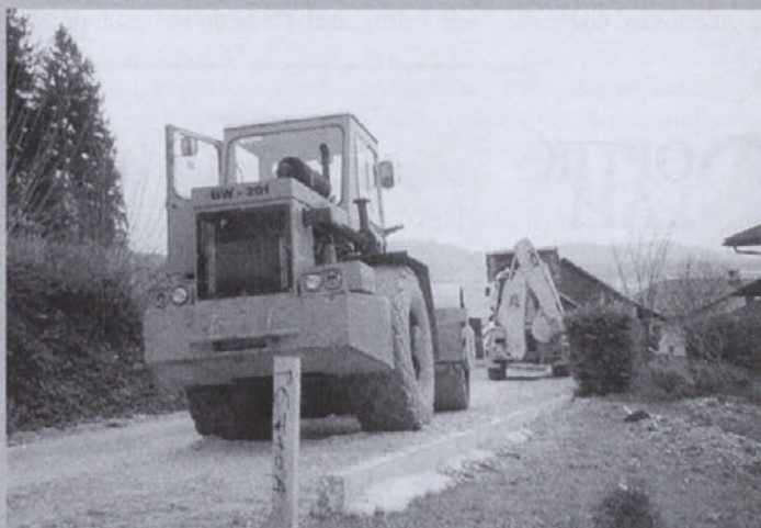
Urejen klanec ceste na Čeren - urejen problem vzdrževanja makadama.
