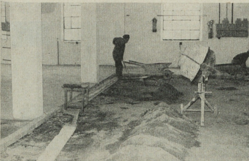
Pripravljalna dela za novo žensko garderobo v prostorih zgornje tkalnice
