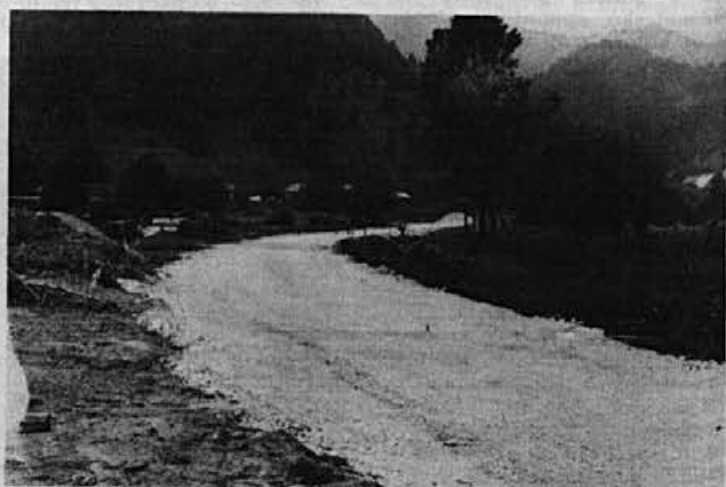
Tudi urejevanje cest v industrijski coni je ta čas v največjem razmahu. Kdaj neki bodo te ceste tudi zares koristne? Vsiljuje se niz vprašanj: preostala oprema industrijske cone, selitev obratov tovarn, povezave posameznih delov cest. Kaj pa obvoznica?
