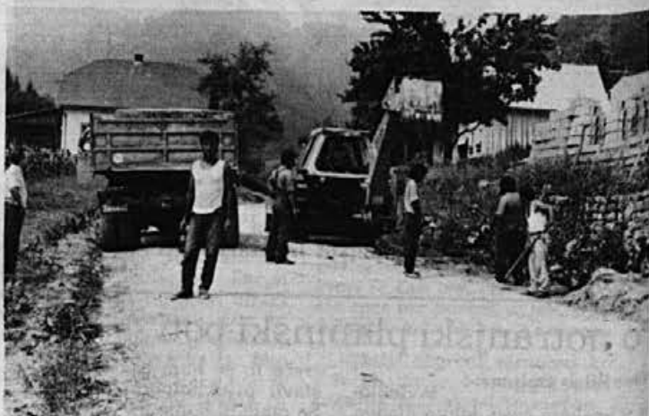
SGP Primorje iz Ajdovščine se je lotilo ureditve ceste skozi Osojnico. Najprej je treba urediti spodnji ustroj cestišča, kanale itd., potem šele pride na vrsto vse ostalo.
