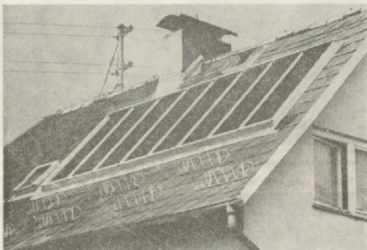
Montaža sončnega kolektorja na poševni strehi
