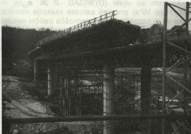
Slika 10: Izvedba prekladne konstrukcije
