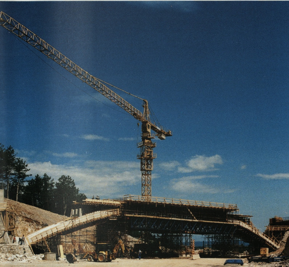
Gradnja nadvoza 4-3 na AC DIVAČA KOZINA
