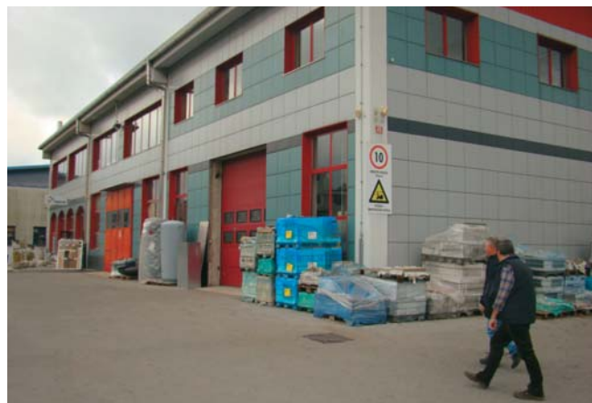
Poslovni objekt Trgocev v OIC Logatec
