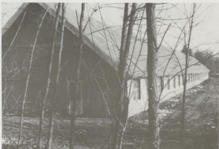
Prvi »vzorčni« kokošnjak kjer so bile stene iz trstike, kritina pa iz slame. Zgrajen je bil v dolinici parka. Vzrejne razmere v zimski burji so bile »nepozabne«. (Vse fotografije foto: Slavko Brglez)
