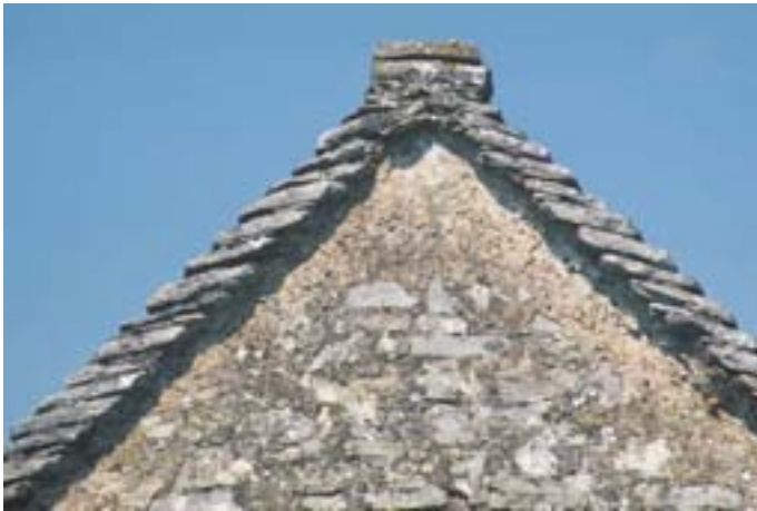
Slika 1: Značilni slemenjak in posebej oblikovani zaključki skrl v zatrejni steni nekdanje komunske kašče v Križu pri Sežani (z datacijo iz leta 1777). Stavba je s prenovo prevzela funkcijo mrliške vežice. Typical ridge slate and specially designed closing slate above the gable wall of the former communal granary in Križ, Sežana (dated 1777). The building took on the function of mortuary chapel after renovation.
