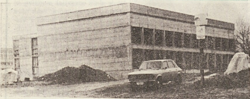
Bazen v telovadnici pri šoli je v tretji fazi gradnje
