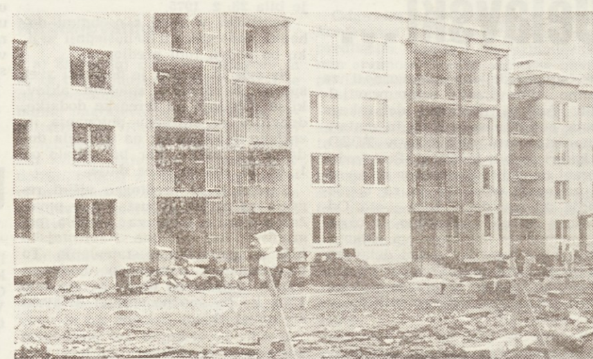
Obrtniška dela na tem bloku gredo h kraju in objekt bo kmalu vseljen
