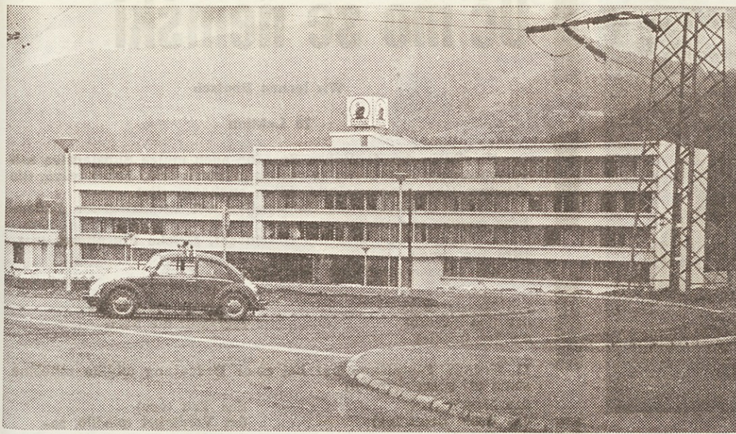
Nova upravna zgradba je pravi okras Železarni
