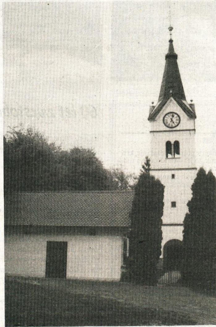
Mrliška vežica je bila zgrajena leta 1995 s samoprispevkom nekaterih krajanov, cerkva pa pred kratkim obnovljena in velja za zanimiv kulturni spomenik.
