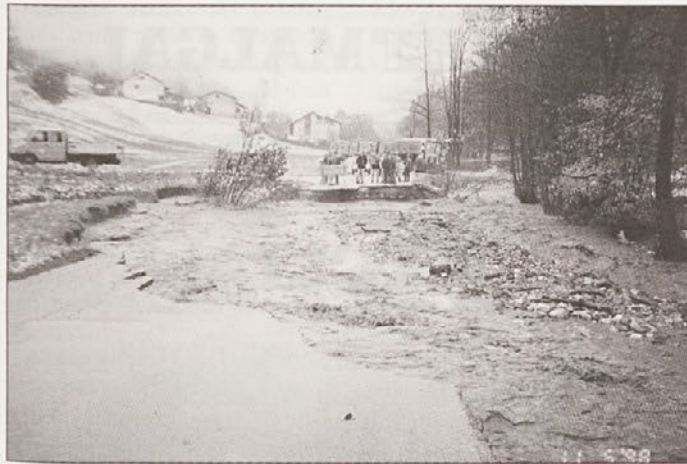
Odtrgana cesta na Rovih (foto PM.)
