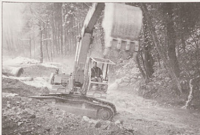
Znojilčani so sami pričeli s sanacijo (foto PRAV)
