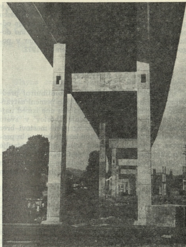
Sl. 13. Pogled na viadukt od spodaj
