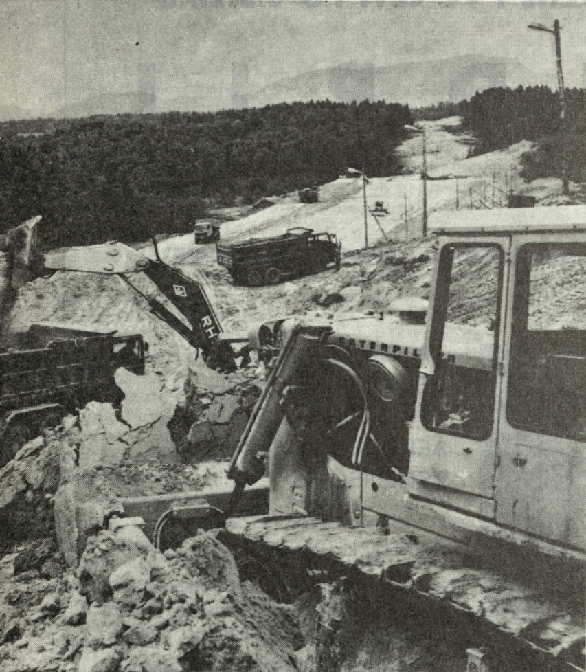
Gradimo avtocesto Hoče—Dravje v dolžini 34,5 km. Izvršili bomo 2.700.000 m 3 izkopov, 2.500.000 m 3 nasipov, od tega 1.300.000 m 3 z apneno stabilizacijo. Vgradili bomo 60.000 m 3 cementne stabilizacije in 130.000 ton asfalta. Vrednost del 300 milijonov din.
