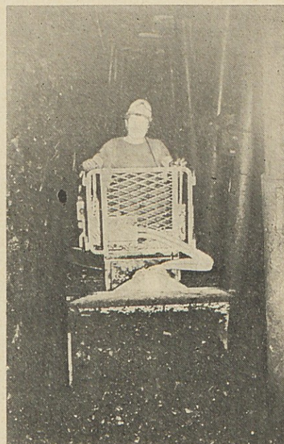
Nakladalec v akciji na širokem čelu v jami Terezija II polje, kota 180. (Foto J. Kirič)
