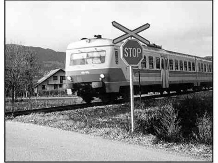
Prehod v Rečici ob Paki proti Polzeli je dokaj prometen, na nevarnost pa opozarjajo le stop znak in Andrejev križ.
