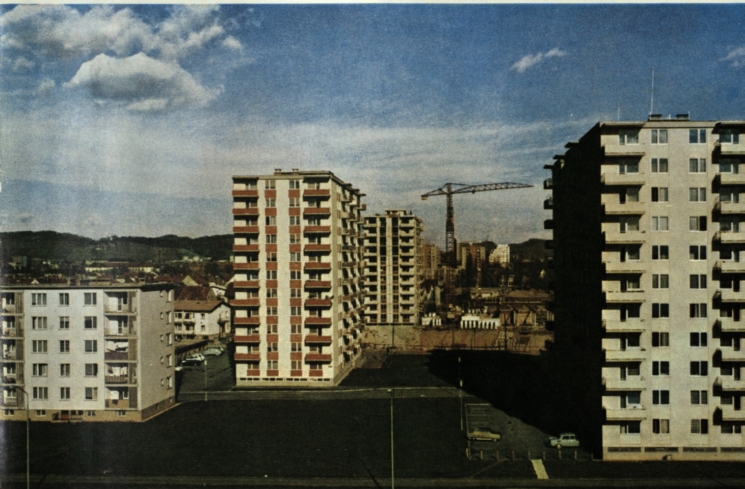
Objekt: Gradbišče S 21 v Mariboru Izvajalec: SGP KONSTRUKTOR Maribor
