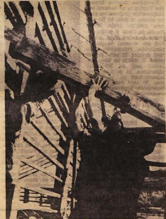
»Deteljo bo zdaj zdaj treba kositi, žito je že v klasju, pri popravilu kozolcev pa smo med zadnjimi.« so povedali možje v soboto, 20. maja, v Artmanji vasi pri Dobrucu, ko so popravljali Lisjakov kozolec. Večina kozolcev je resda že obnovljenih in sledov strašne lanske noči, ko je neurje podrlo čez 40 kozolcev, kmalu ne bo več. (Foto: M. Legan)
