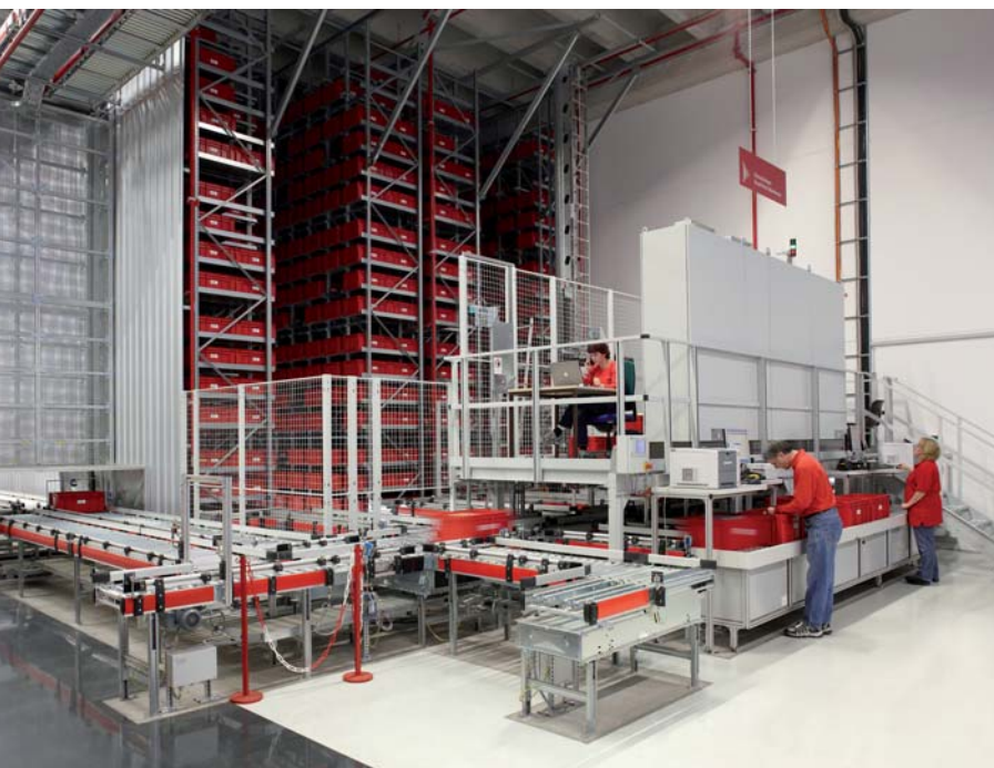
V novem logističnem centru je tudi avtomatsko skladišče drobnega materiala.
