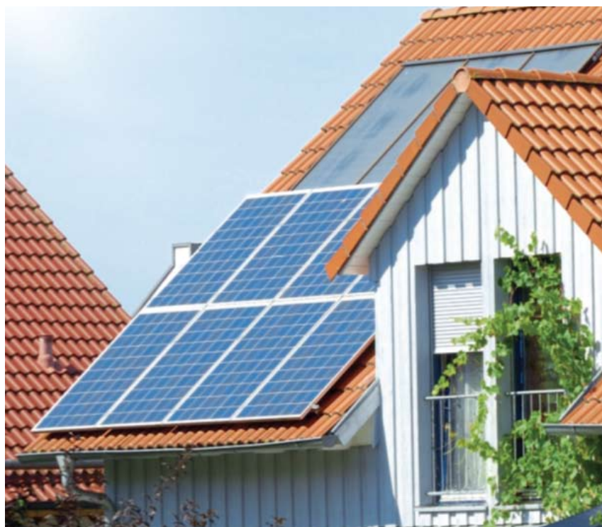
Slika 1: Na številnih strehah najdemo poleg PV-naprav tudi sončne kolektorje (na sliki so nameščeni nad PV-moduli), ki sončno energijo spreminjajo v toploto. (Vir: EATON)
