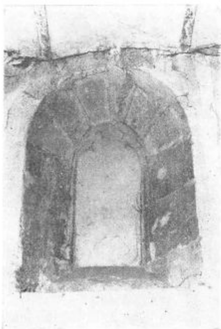
Sl. 32. Zazidano bazilikalno okno nad severno stransko ladjo.
