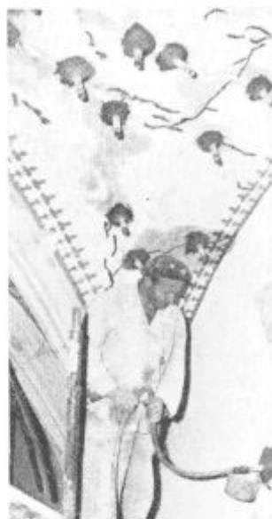
Sl. 17. Injiciranje oboka v srednji ladji. Na delu je ekipa zavoda za raziskavo materiala in konstrukcij iz Ljubljane.
