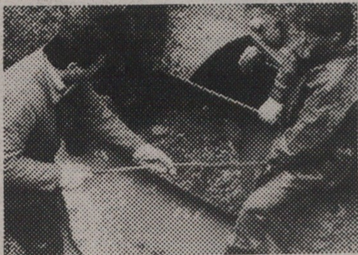
Delavci stanovanjsko komunalnega podjetja so takole s posebno pripravo čistili zamašene kolektorske cevi.
