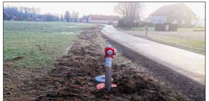
Obnova vodovodne linije – Obrež
