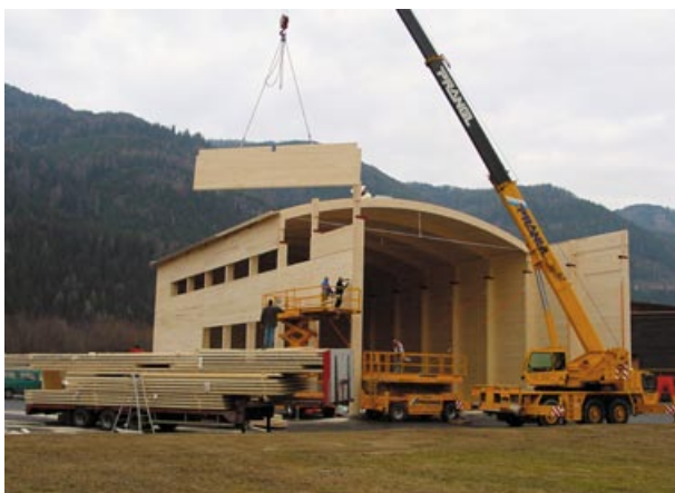
■ Slika 9. Objekti večjih dimenzij in razponov z nosilno konstrukcijo iz križno lepljenih lesnih KLH plošč (levo proizvodna hala v Avstriji in desno hipodrom na Švedskem)
