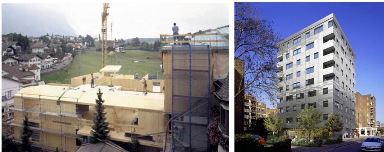
■ Slika 10. Večnadstropni stavbi z nosilno konstrukcijo iz križno lepljenih lesnih KLH elementov, ki sta bili zgrajeni v ožjih mestnih jedrih (levo hotel Lamm v Italiji in desno render že zgrajene 9-nadstropne stavbe v centru Londona, v kateri je osem zgornjih etaž iz KLH plošč)
