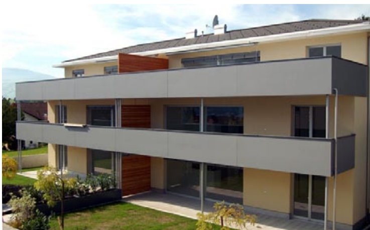
■ Slika 8. Večnadstropni stavbi z nosilno konstrukcijo iz križno lepljenih lesnih KLH plošč (zgoraj 4-etažni stanovanjski blok v Avstriji in levo 3-etažni v Liechtensteinu)
