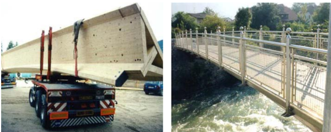
■ Slika 12. Premostitveni nosilec in most iz križno lepljenih lesnih KLH elementov.
