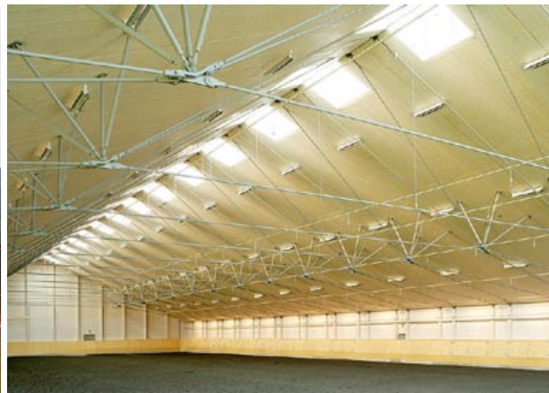
■ Slika 9. Objekti večjih dimenzij in razponov z nosilno konstrukcijo iz križno lepljenih lesnih KLH plošč (levo proizvodna hala v Avstriji in desno hipodrom na Švedskem)
