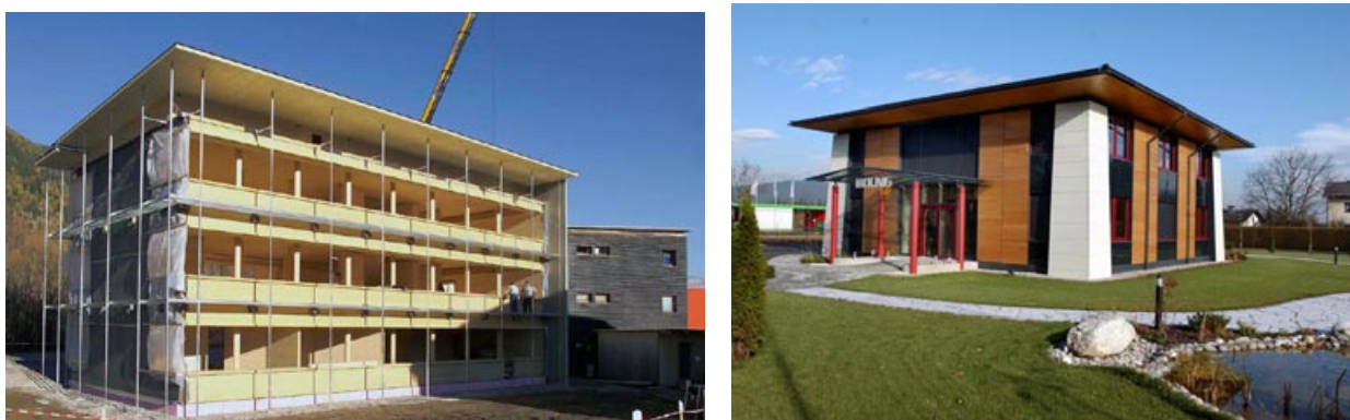
■ Slika 11. Poslovni stavbi z nosilno konstrukcijo iz križno lepljenih lesnih KLH elementov zgrajeni v zelo kratkem času - nosilna konstrukcija je bila postavljena v manj kot tednu dni (levo poslovni KLH objekt pri Katschu v fazi montaže in desno zaključen biro v Celovcu).
