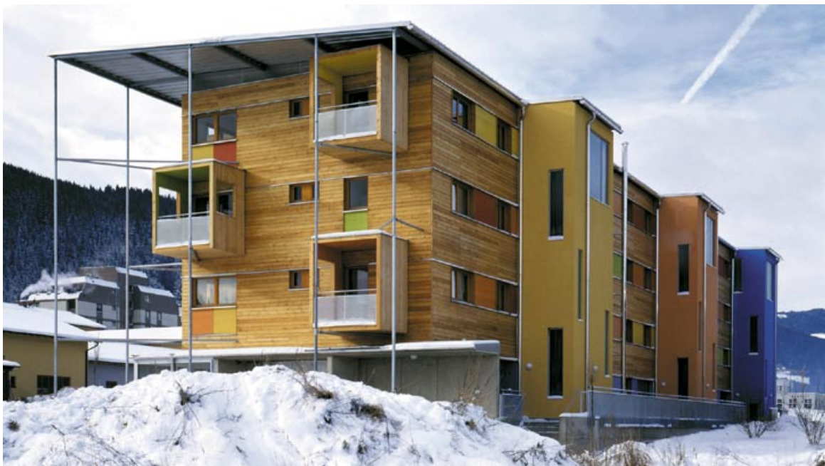
■ Slika 8. Večnadstropni stavbi z nosilno konstrukcijo iz križno lepljenih lesnih KLH plošč (zgoraj 4-etažni stanovanjski blok v Avstriji in levo 3-etažni v Liechtensteinu)
