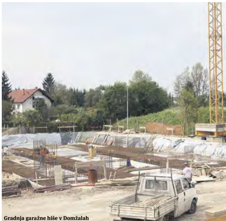
Gradnja garažne hiše v Domžalah
