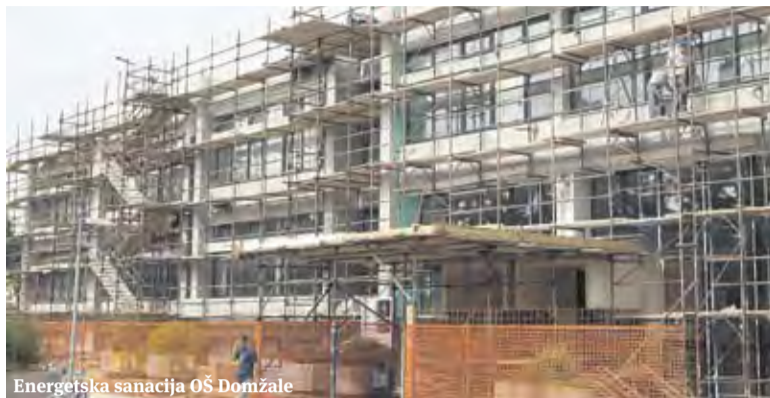
Energetska sanacija OŠ Domžale
