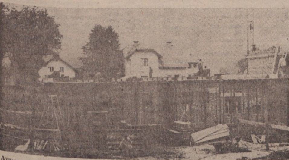
Avgusta je stavba že krepko pogledala »na svetlo«.
