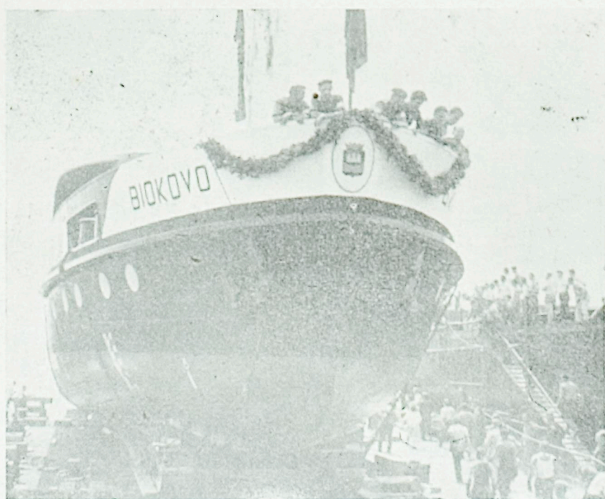
Rečni vlačilec »Blokovo«, ki so ga izdelali marljivi piranski ladjedelci za Donavski Lloyd, sodi ne le med naše najbolj sodobne plovne objekte, ampak je hkrati tudi največji rečni vlačilec, izdelan v naši državi. Močni stroji, ki poganjajo tri vijake, dajejo »Blokovu« izredno vlečno moč, saj ima lahko v navezu v plovi proti toku reke Donave enajst in celo več »slepov«. Na sliki: prvo srečanje »Blokova« z mokrini elementom v Portoroškem zalivu
