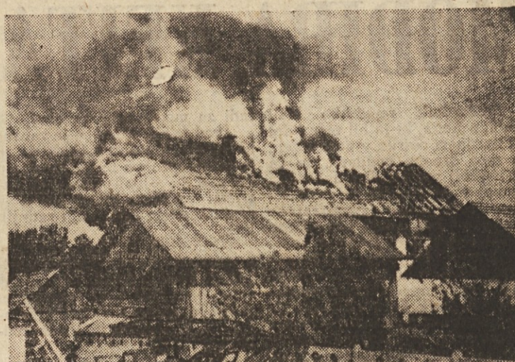
Minuli teden je v kranjski tovarni Roleta izbruhnil velik požar. Domnevajo, da je požar nastal v lakirnici, ko je neki delavec vrtal cev zračne napeljave. Pri tem so razžarjeni opilki leteli na vse strani in eden izmed njih je padel v škatlo, kjer so bili še ostanki nitrolaka. To je bilo usodno. Delavec je hotel ogenj zadušiti, vendar je bil nemočen. Škodo cenijo doslej na približno 20 milijonov dinarjev.
