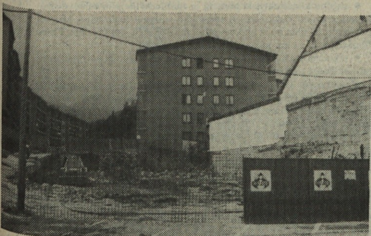
Lokacija na Trgu svobode na Ravnah, kjer bo v šestih mesecih zgrajeno novo pošto poslopje.
