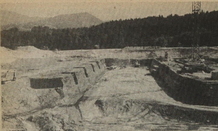
Izgled gradbene jame po zaključenem izkopu. Na gradbišču je podoba zdaj še drugačna in se bo spreminjala iz dneva v dan.
