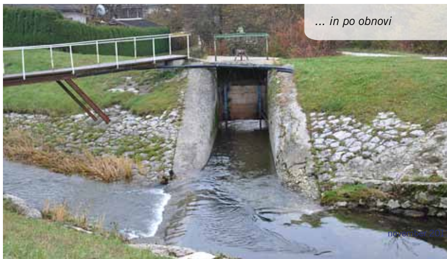
Zapornica pred obnovo ...
