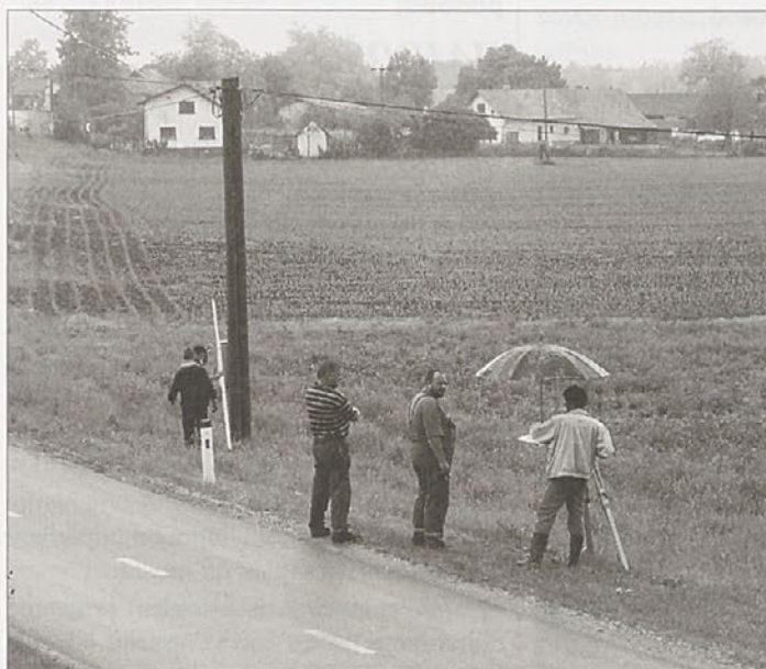
Zakoličenje trafo postaje in trase kablovoda
