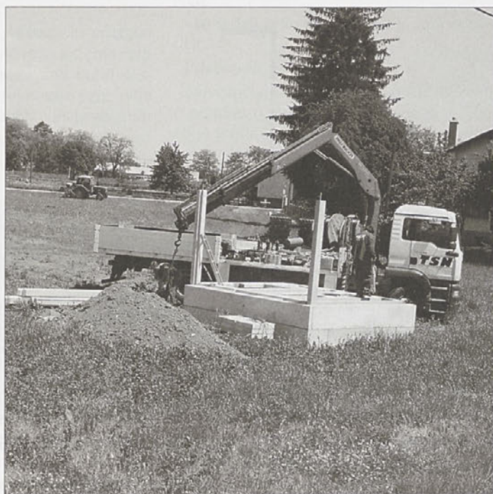
Začetek zemeljskih del. Foto: Občinska uprava
