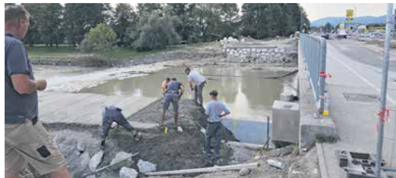
Priprava terena za začasni most na cesti Domžale–Vir
