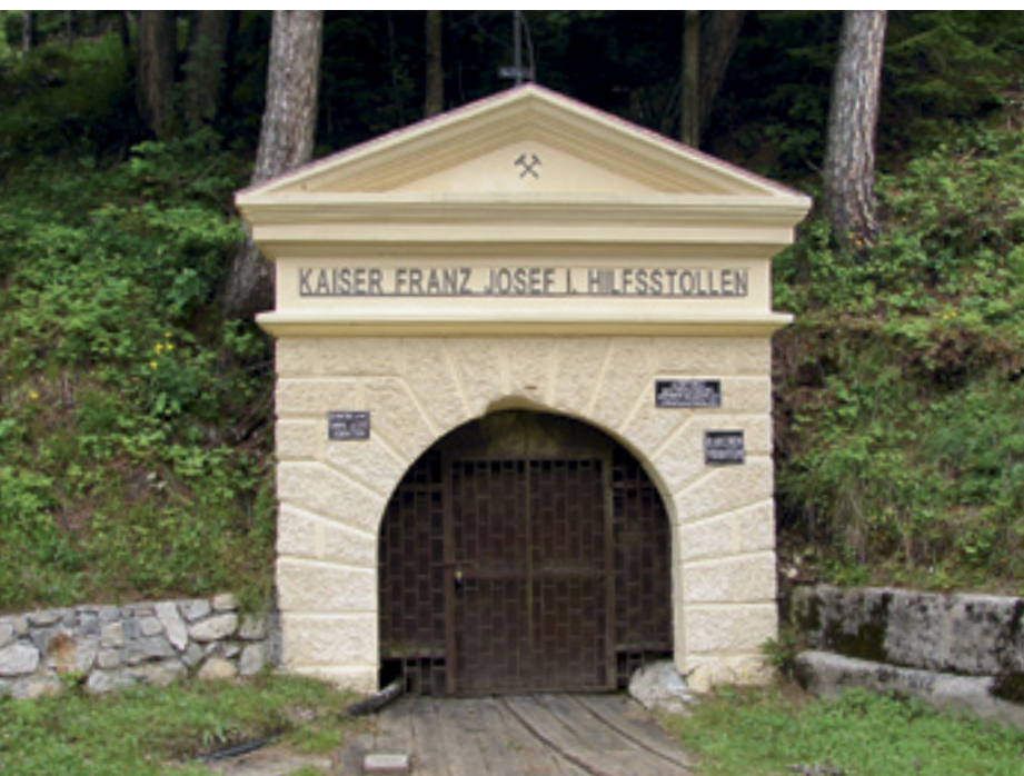
Obnovljeni portal vhoda v predor v Logu pod Mangartom
