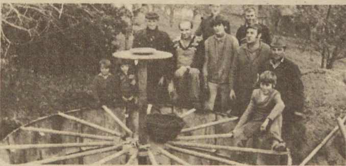
Prebivalci zaselka Benkov breg v Šušincih so to jesen končali z gradnjo bazena za gašenje. Cement je prispevalo šušinsko gasilsko društvo.
