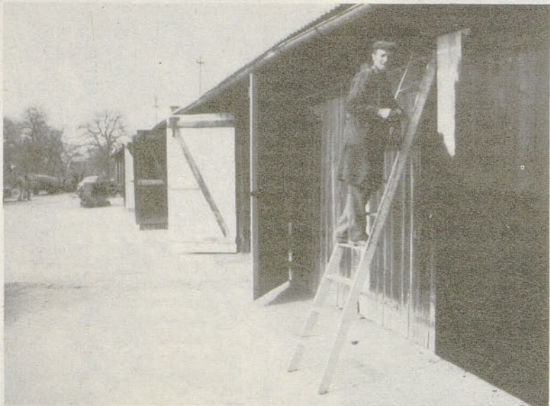
Po vseh TZO KZ Savinjska dolina se pripravljajo na zimo: čistijo stroje, popravljajo žičnice in pripravljajo gradivo za nove ter popravljajo stavbe. Na fotografiji: še par potegov s čopičem in strojna lopa bo s sadolincem zavarovana pred vremenskimi vplivi.
