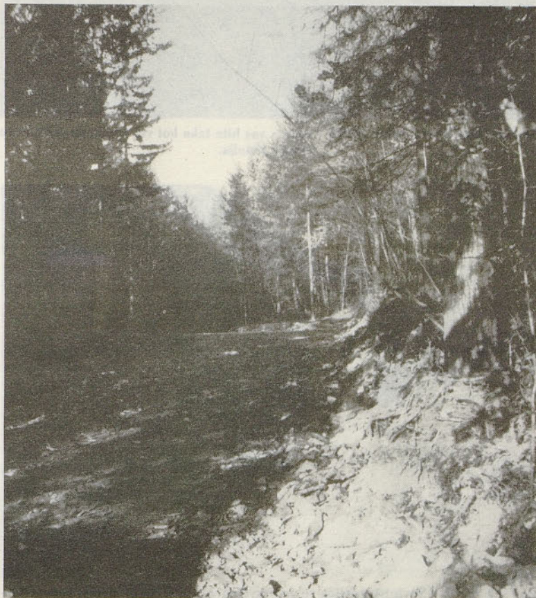
Cesta Korber-Brdovšek in povezava na Novi Klošter in Sevčnik je v grobem končana.
