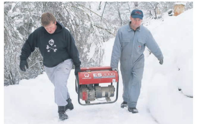
Zasilna rešitev začasno električno oskrbo: sosedov agregat. Na levi sin Martin, na desni Danijel Rožič.
