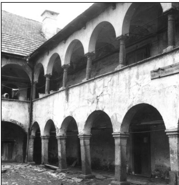
Pogled na arkadno dvorišče z nagnjenimi stebri leta 1988 (fototeka ZVKDS, OE Kranj).
