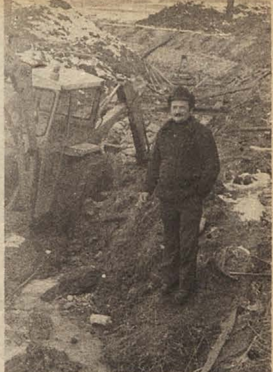
STRUGA BO UREJENA – Vodna skupnost Dolenjske je v Brusnicah sredi obsežnejšega dela pri regulaciji potoka. Na trasi v dolžini okrog 300 m delajo tudi pozimi, če le ni izredno slabega vremena. Potok je potrebno regulirati, ker večkrat poplavlja in blizu gradijo šolo. (Foto: Bačer)
