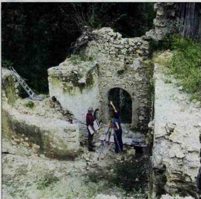
Že čiščenje gradu je bilo zahtevno, saj so bile zaradi krušenja kamena v nevarnosti hiše na samem trgu Lemberga. Zato je pred temeljito prenovo treba dobro preveriti statičnost objekta.
