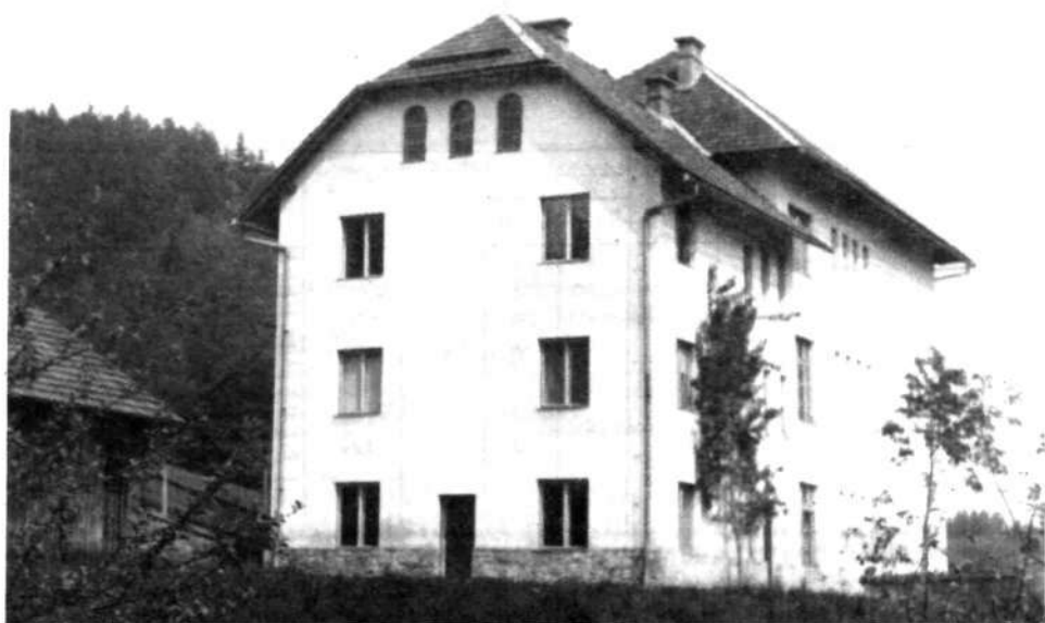
Stavba osnovne šole Sovodenj, zgrajena leta 1939 (Fototeka Slovenskega šolskega muzeja, inv. št. 2318)
