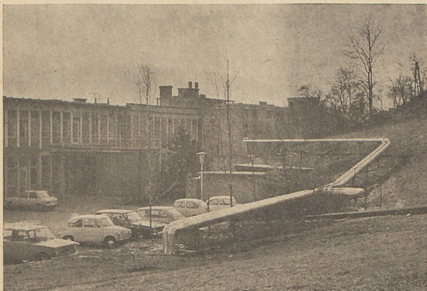
Odsek magistralnega toplovoda, ki poteka iz toplarne TOZD ESD v naselju Opekarna čez Trg revolucije, ob Ulici 1. junija in Rudarski cesti zadaj otroške bolnišnice do osrednjega objekta splošne bolnišnice v Trbovljah. Toplovod je pričel obratovati v drugi polovici decembra 1974. Preko tega toplovoda toplarna že ogreva vrsto objektov. Na sliki odsek toplovoda zadaj otroške bolnišnice. (Foto M. C.)
