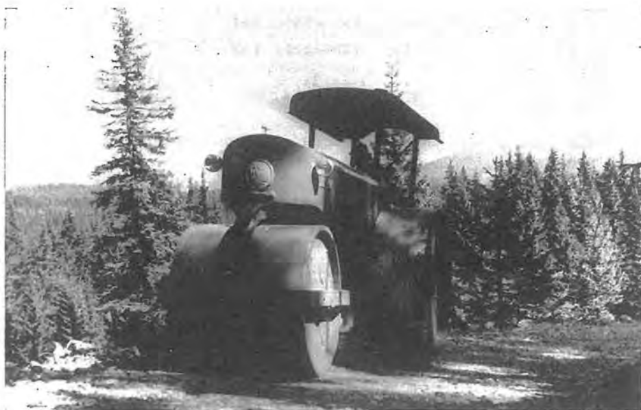
Valjanje makadama s težkim motornim valjarjem
