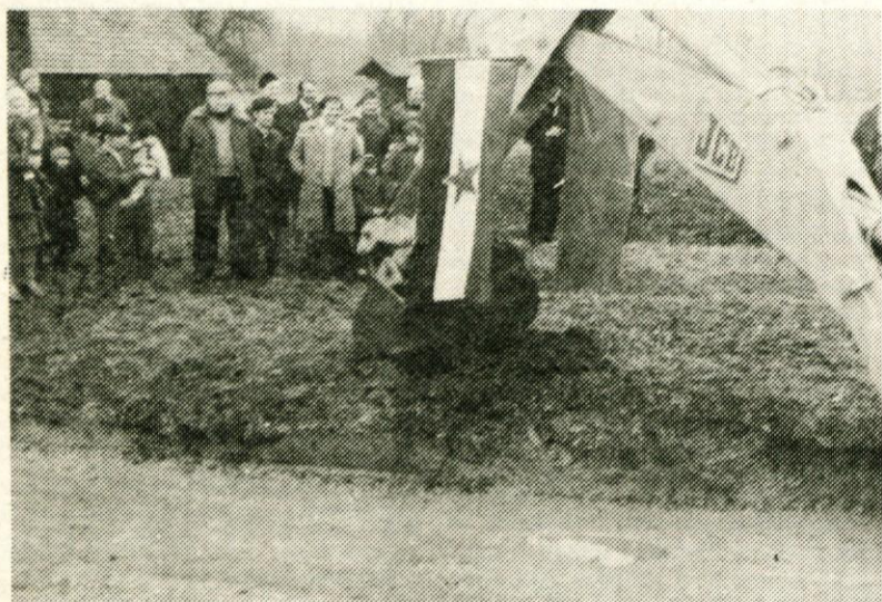
Začetek gradnje na cesti proti Trojici
