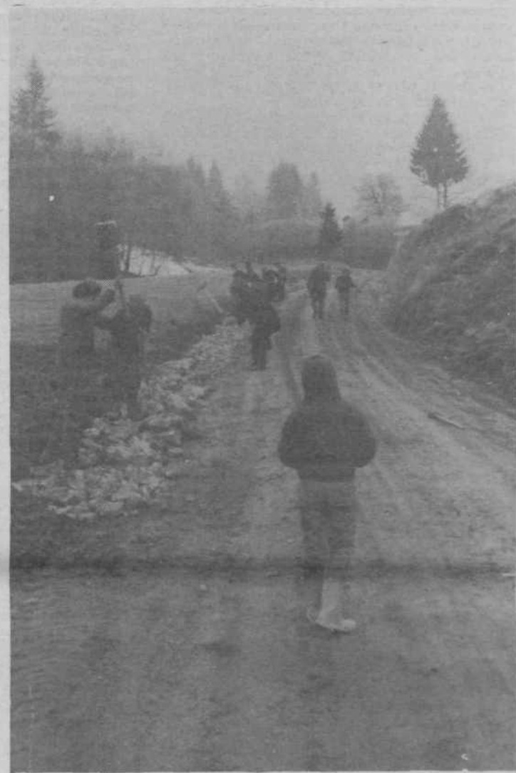
Marljivi vaščani pri pripravi ceste Dob-Hrastov Dol za asfaltiranje
