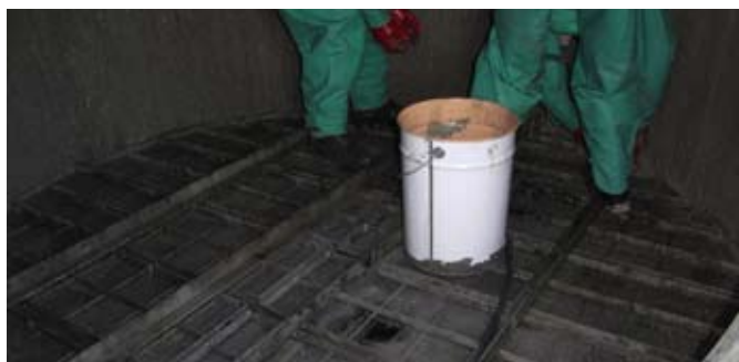
Zahtevno in nevarno delo pri demontaži in montaži DEMISTER filtrov
