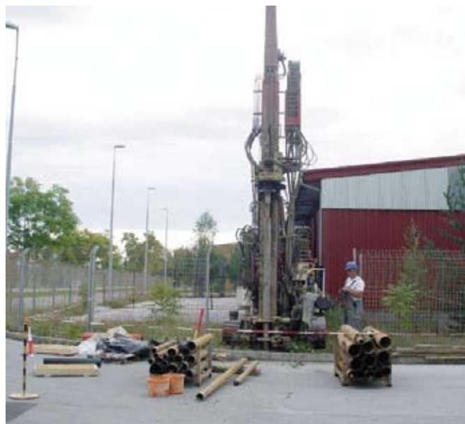
Vrtanje stalnih vodnjakov
