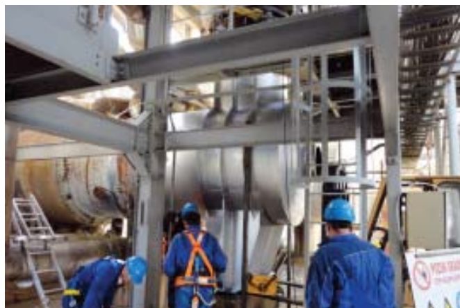
Montaža dimne komore na kotel
