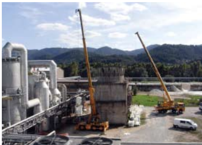
Pomoč avtodvigel pri sejanju katalizatorja
