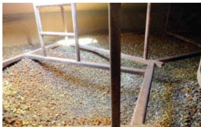
Pred demontažo katalizatorja
