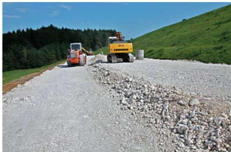
Gradnja nasipa na pregradi Za Travnik
