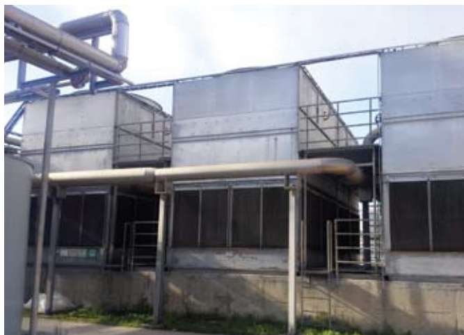
Hladilni stolpi v proizvodnji \text{H}_2\text{SO}_4
