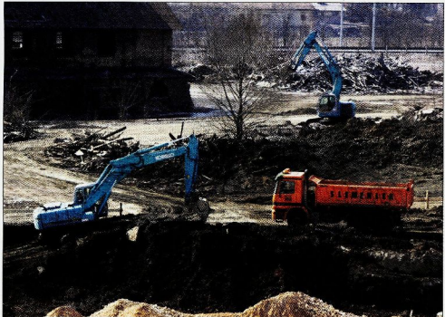
Na slabem pet hektara zemljišč je nastala gradbeno jama, izkopalno zemljo pa so prepeljali na približno sto metrov oddaljeno začasno deponijo.
