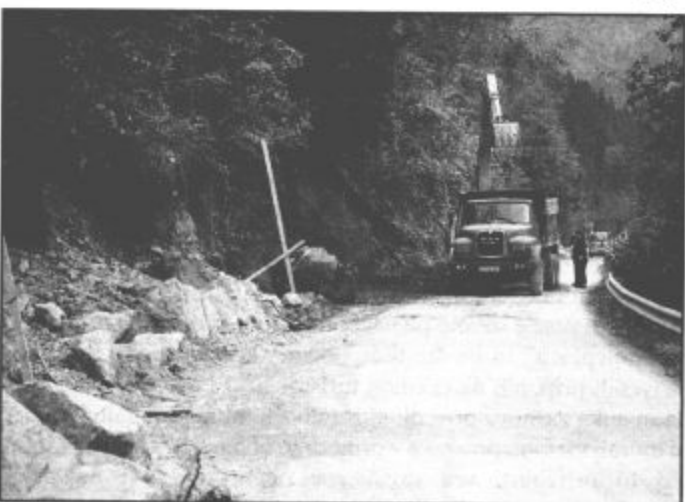
Občasni zastoji ljudi ne motijo preveč, da se le gradi
