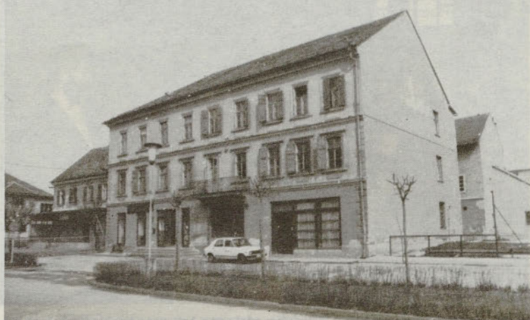
Stavba nasproti železniške postaje Žalec pred obnovo.
