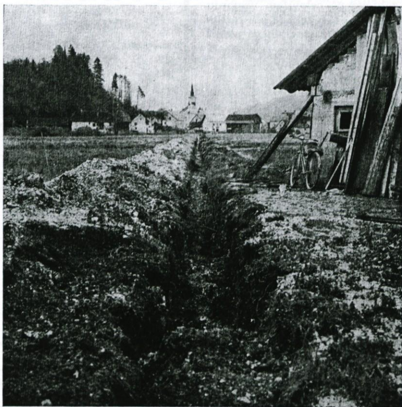
Izkop za novo vodovodno omrežje v Gor. Logatcu
