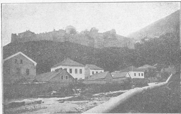
Sl. 3. Električna centrala na izvoru Šumeća ispod gradske tvrđave
