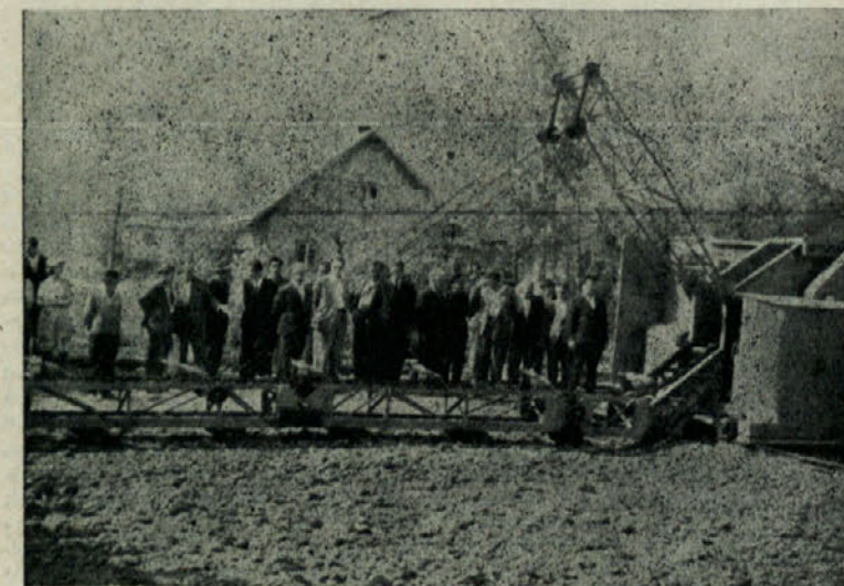
V Opekarni je začel obratovati nov bager (Foto: »Novice«)
